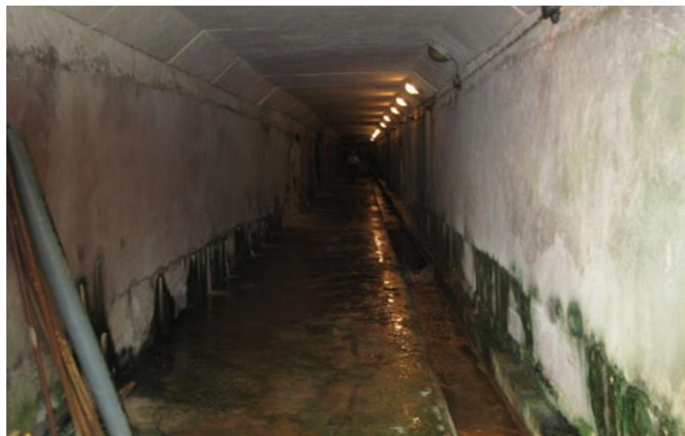
Рисунок 5.3 - Фильтрации воды в потернах бетонной плотины
