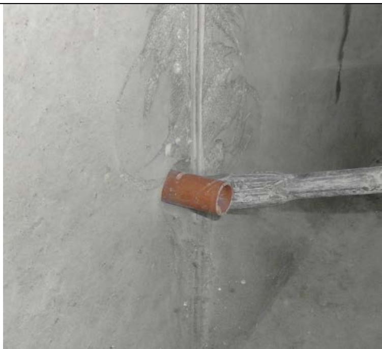
**Рисунок 7.2.53 - Удаление пластиковой втулки**
