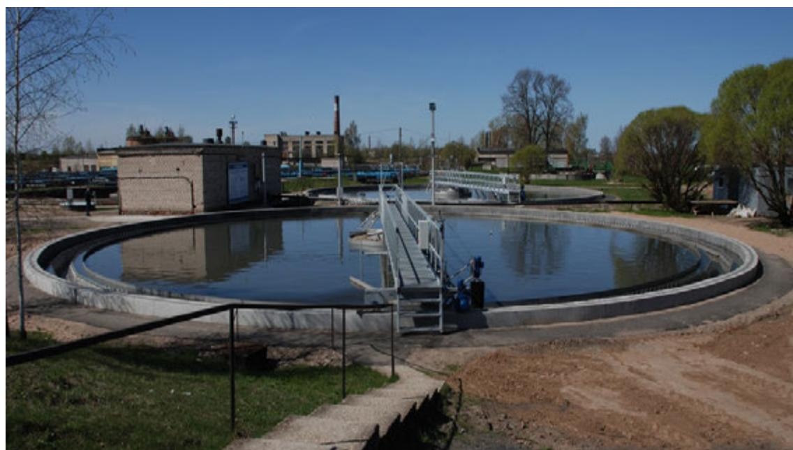
**Рисунок 6.4.1 - Радиальный отстойник из монолитного железобетона:**
