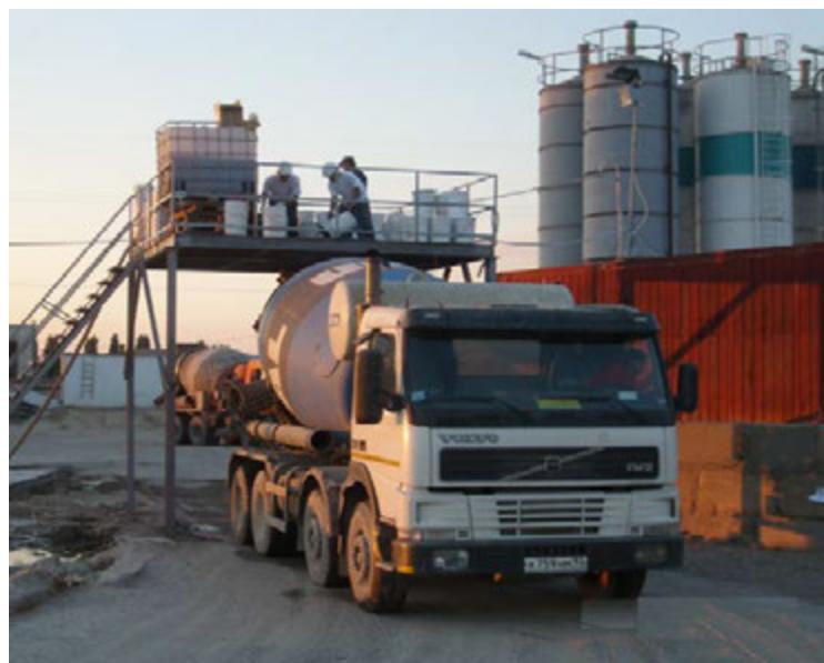
Рисунок 7.1.2 - Пример введения добавки «Пенетрон Адмикс» в автомиксер
