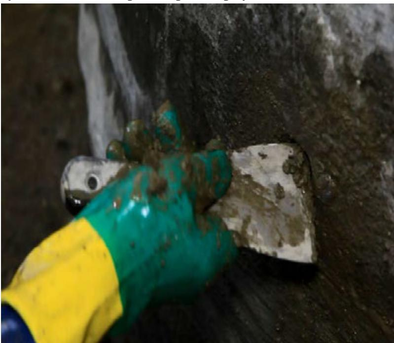
**Рисунок 7.2.39 – Удалить остатки растворной смеси из полости течи**
