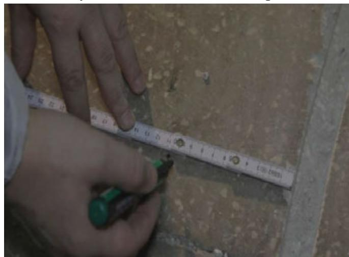
**Рисунок 7.2.21 – Выполнение разметки для установки инъекторов**
