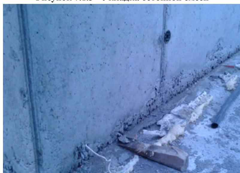
Рисунок 7.1.4 - Непровибрированный участок бетона (место, где наиболее вероятны протечки воды)
