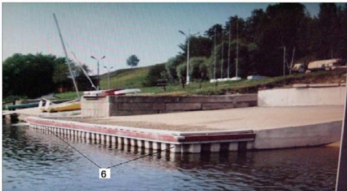
**Рисунок 6.5.3 - Причальные сооружения на железобетонных сваях:**
