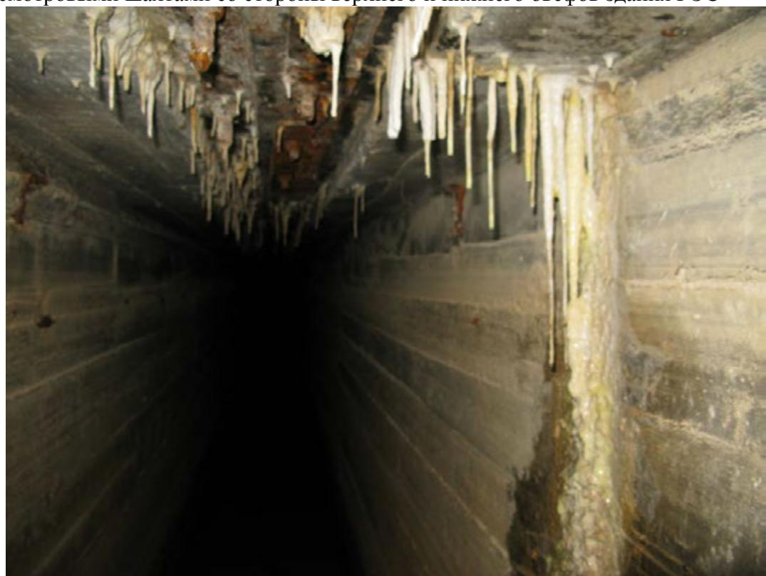
Рисунок 5.2 - Фильтрация воды с выносом окиси гидрата кальция через швы бетонирования и из-под потолочного уплотнения деформационного шва в соединительном коридоре между смотровыми шахтами верхнего и нижнего бьефов
