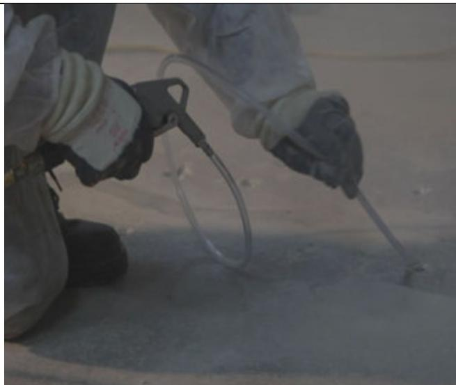
**Рисунок 7.2.23 – Очистка отверстий сжатым воздухом от остатков бурения**
