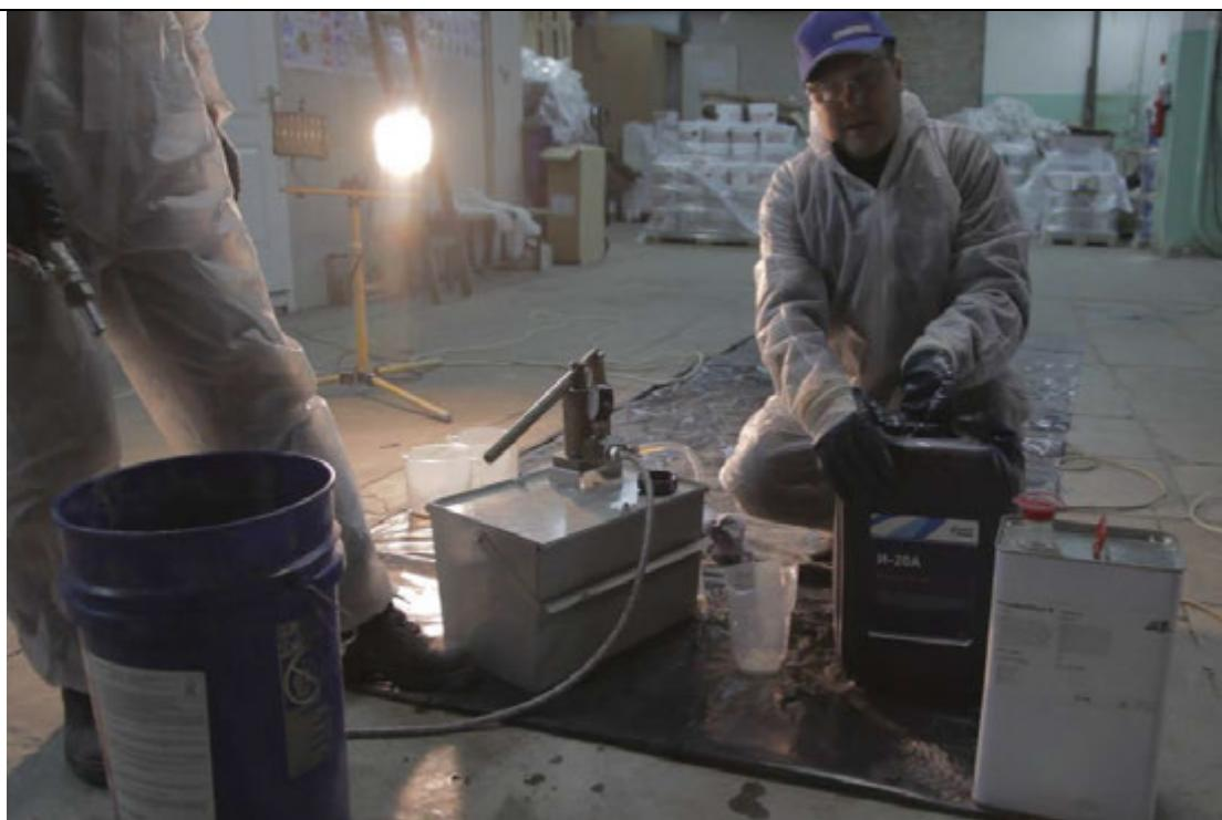
**Рисунок 7.2.28 - Промывка гидравлическим маслом**
