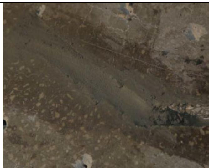
**Рисунок 7.2.26 – Штраба, заполненная растворной смесью «Скрепа М500 Ремонтная»**
