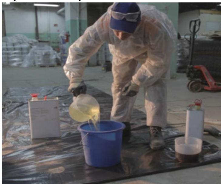
**Рисунок 7.2.30 – Дозирование компонентов смолы**
