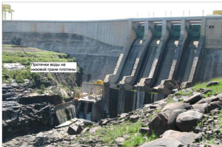
**Рисунок 6.2.1 - Плотина из укатанного бетона**
