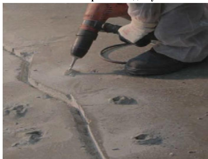
**Рисунок 7.2.22 – Бурение отверстий для установки инъекторов**
