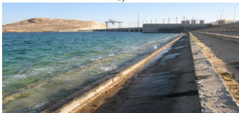
**Рисунок 6.6 - Железобетонные крепления откосов грунтовых плотин:**
