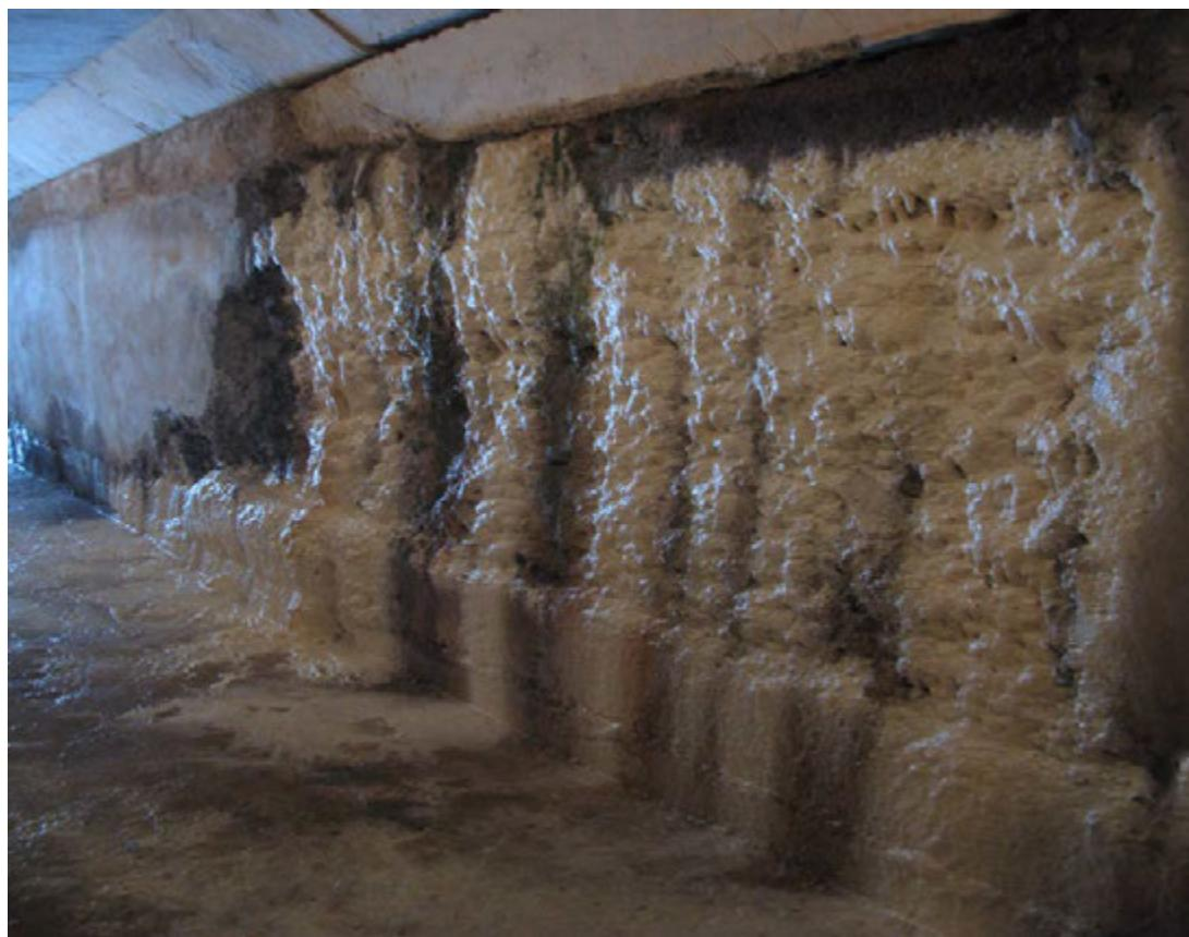
Рисунок 5.5 - Фильтрация воды по шву бетонирования между стеной и перекрытием потерны
