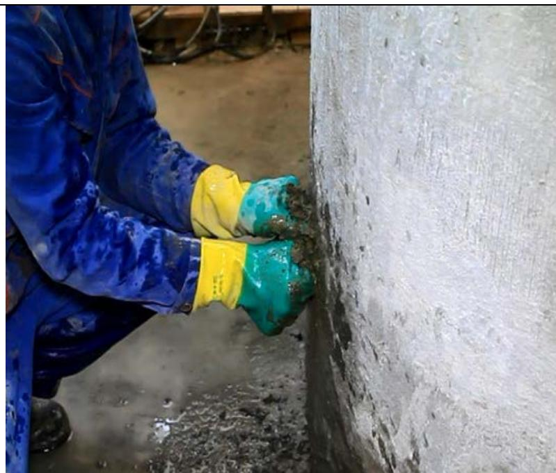
**Рисунок 7.2.38 – Удержать растворную смесь в полости течи**
