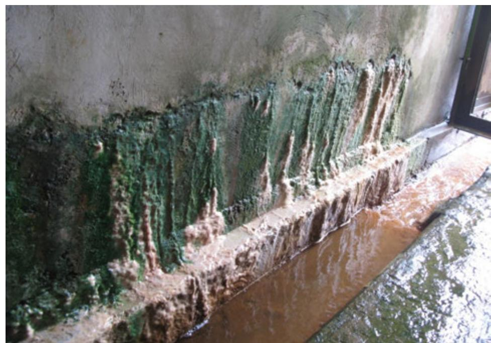
Рисунок 5.4 - Фильтрация воды через горизонтальные швы бетонирования в потерне бетонной плотины
