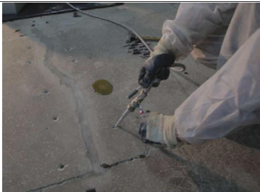
**Рисунок 7.2.31 - Выполнение инъекционных работ**
