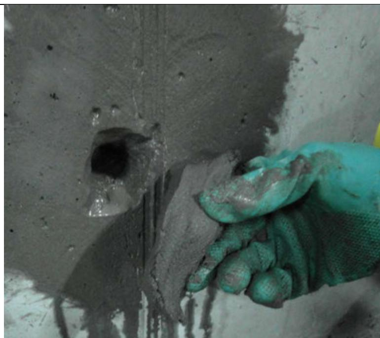
**Рисунок 7.2.55 - Заполнение отверстия**
