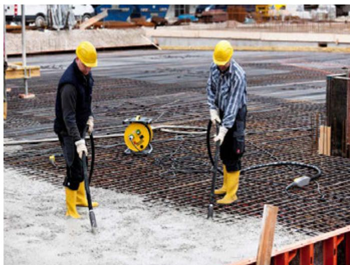
Рисунок 7.1.3 - Укладка бетонной смеси
