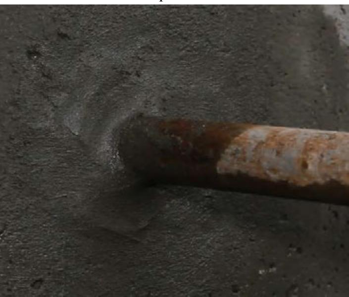
Рисунок 7.2.50 - Заполнение штрабы растворной смесью «Пенекрит»
