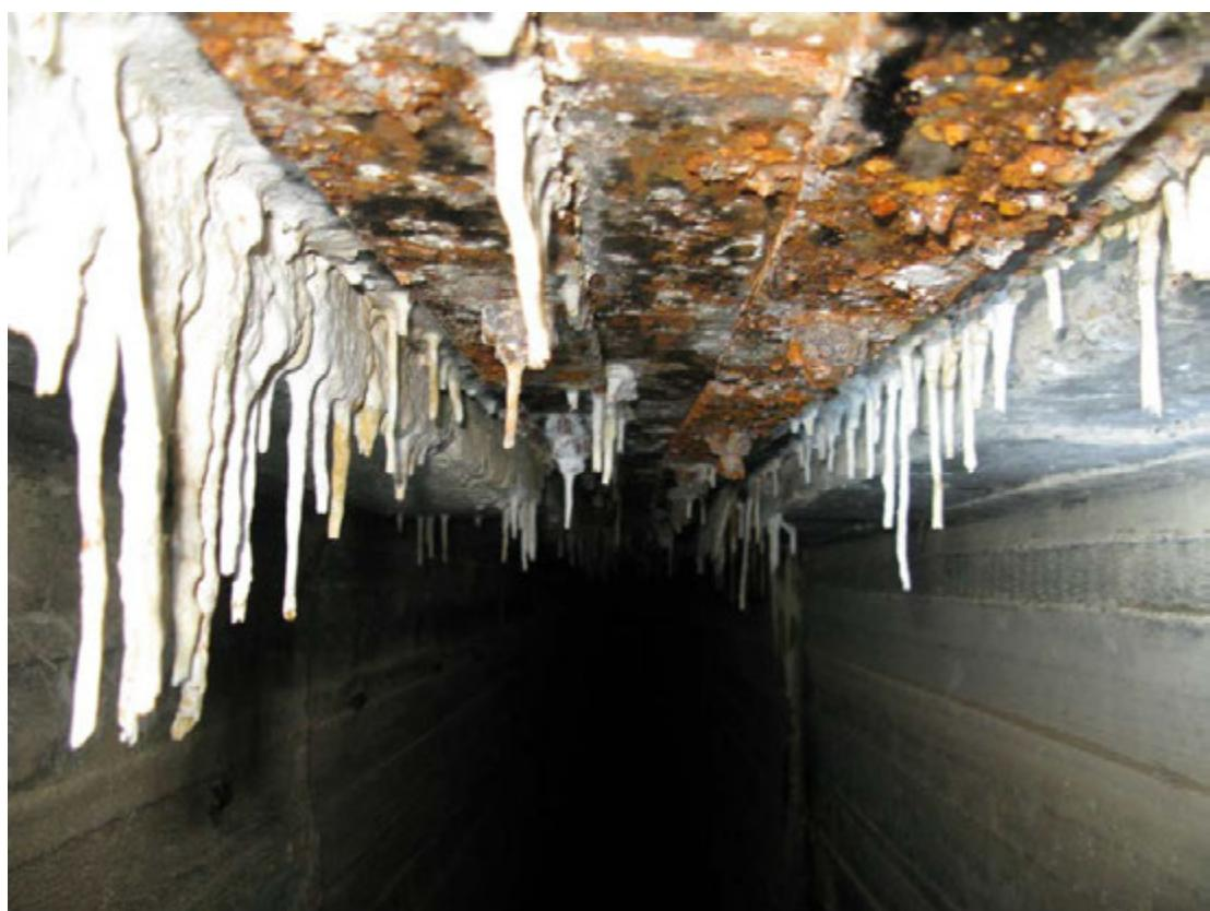
Рисунок 5.1 - Фильтрация воды через потолочное уплотнение деформационного шва с выносом гидрата окиси кальция и образованием «сталактитов» в соединительном коридоре между смотровыми шахтами со стороны верхнего и нижнего бьефов здания ГЭС
